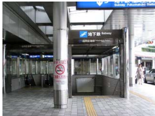
(6) 地下铁筑肥线入口
